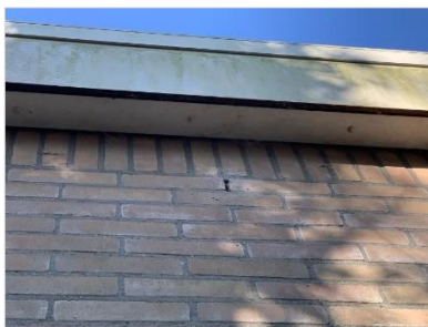
Figuur 4.4 Open stootvoeg in het gebouw op AWTG Weteringbrug
