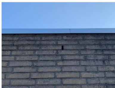
Figuur 4.3 Open stootvoeg in het uit baksteen opgetrokken gebouw op AWZI Leimuiden.
