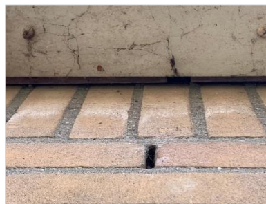
Figuur 4.5 Open stootvoeg en opening tussen muur en boeiboord in het gebouw op AWTG Leimuiden
